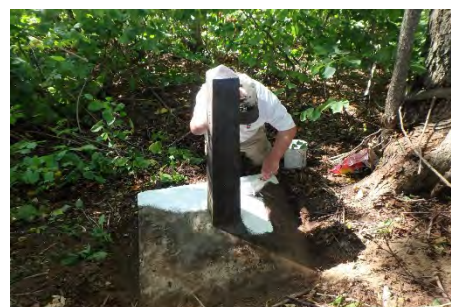
Figure 2 - Reconstruction d’une borne de référence
