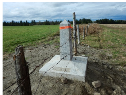
Figure 7: Borne frontière 545 après restauration
